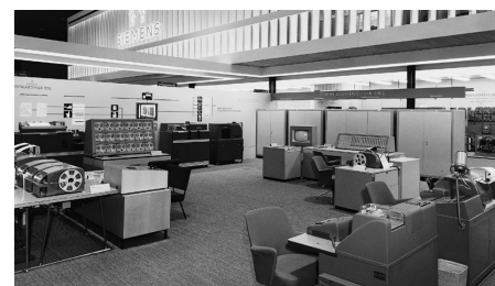
R2002, der erste volltransistorisierte Digitalrechner von Siemens.
