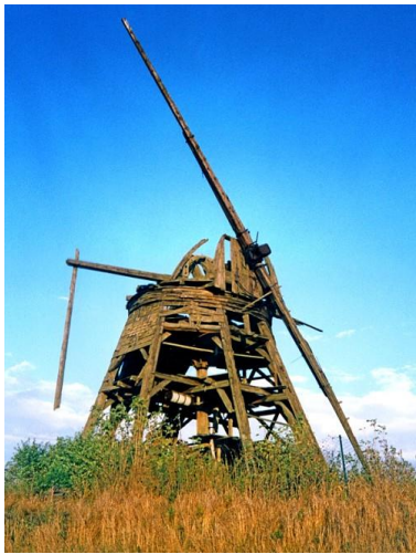
Zustand der Greiffenberger Mühle im Jahr 1980
