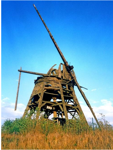
Zustand der Greiffenberger Mühle im Jahr 1980
