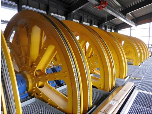
Bild 9: Blick in eine der beiden Seilrollenhallen
