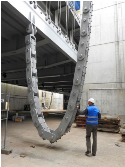
Bild 14: Da sich das Eigengewicht der 224 Seile umso mehr auf die Trogseite verlagert, je tiefer der Trog steht, werden diese massiven Seilausgleichketten verwendet, um das Gleichgewicht in jeder Trogposition zu sichern. Diese Ketten sind 40 m lang und wiegen ca. 1 Tonne pro Meter.
