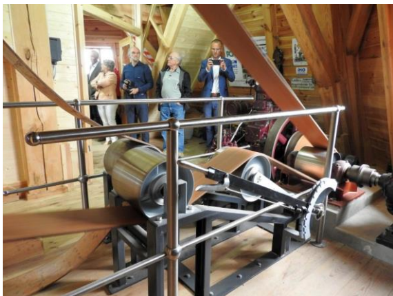
In der Mühle wurde die Antriebsanlage durch Bernd Strack und Reinhard Roland mit Hilfe des Elektromotors in Bewegung gesetzt.
