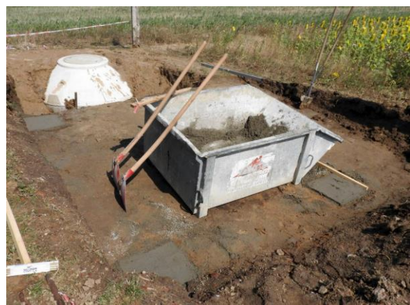
Hier sind die Fundamente für den Container schon mit Beton gefüllt.
