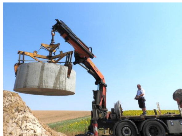
Zuerst wird das Behälterunterteil mit dem LKW-Ladekran in die Grube gesetzt.
