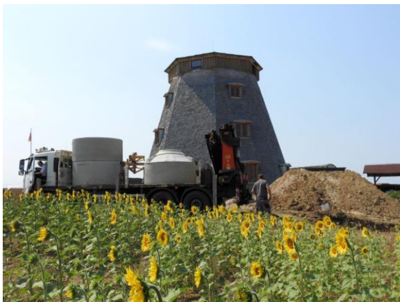
Anlieferung der Behälterringe
