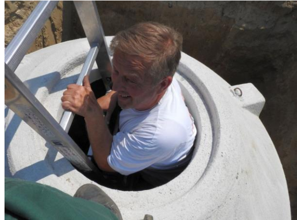
Fred Günther hat die Fugen von innen abgedichtet.
