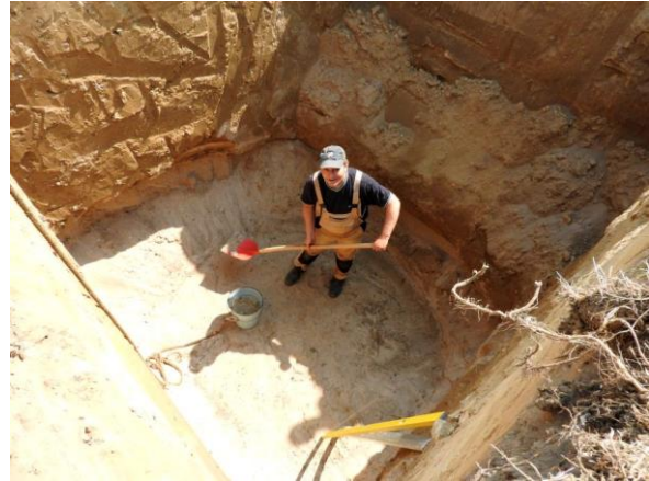
Ingo plant in der Grube die Bodenfläche für den Abwasserbehälter.
