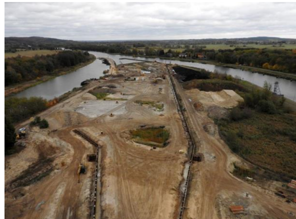
Bild 18: Hier entsteht der untere Vorhafen.
