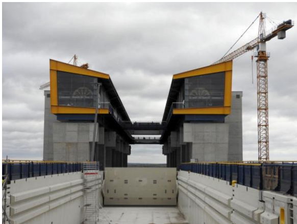
Bild 15: Blick von der Kanalbrücke auf die beiden Seilrollenhäuser.
