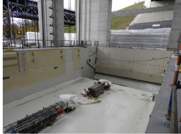
Bild 11: Der Trog hat zwei Drehsegmenttore.
