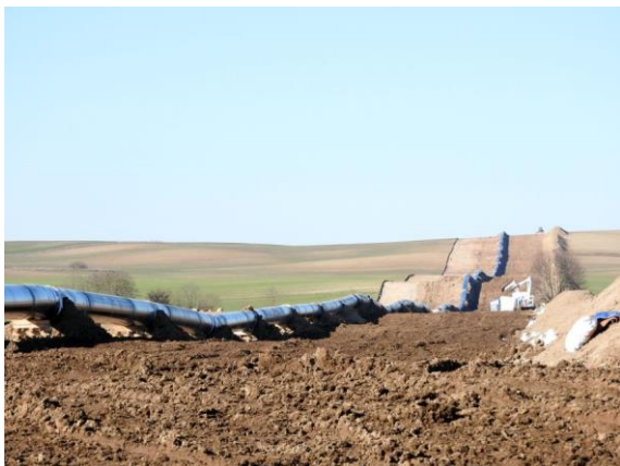
Verlegung der EUGAL-Leitung beim uckermärkischen Dorf Biesenbrow
