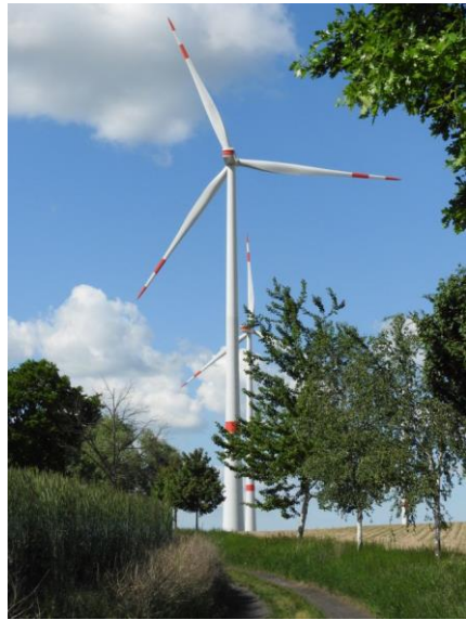
Die fünf Senvion-Anlagen leisten je 3,2 MW und erreichen eine Gesamthöhe von 200 m.
