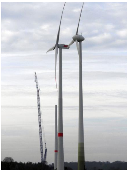
Im Hintergrund die im Bau befindliche E138-Anlage. Im Vordergrund eine alte E40-Anlage mit dem der eiförmigen Generatorhaus und in der Mitte eine 3,2 MW-Senvion-Anlage
