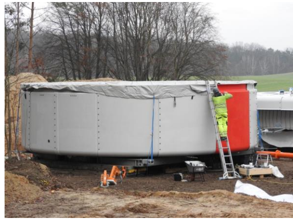
Hier noch am Boden: Der gewaltige Stator des 4,2 MW-Generators.
