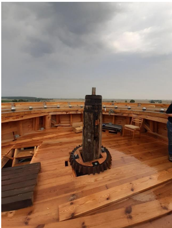
Die Königswelle ist eines der wenigen Originalbauteile, die 2006 nach dem Blitzeinschlag gerettet werden konnten und die noch verwendbar waren.
