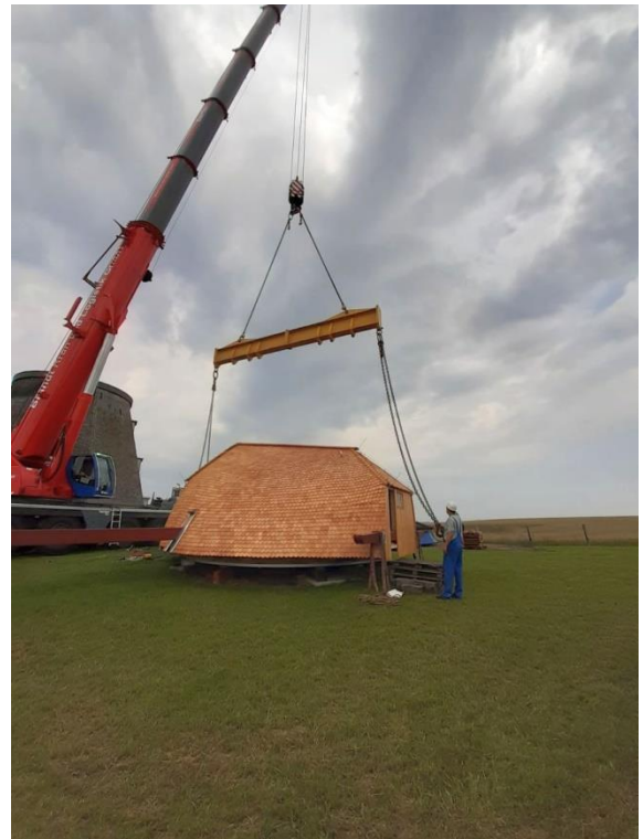
Die Kappe wird nun mit vier Seilen an die Traverse angehängt.
