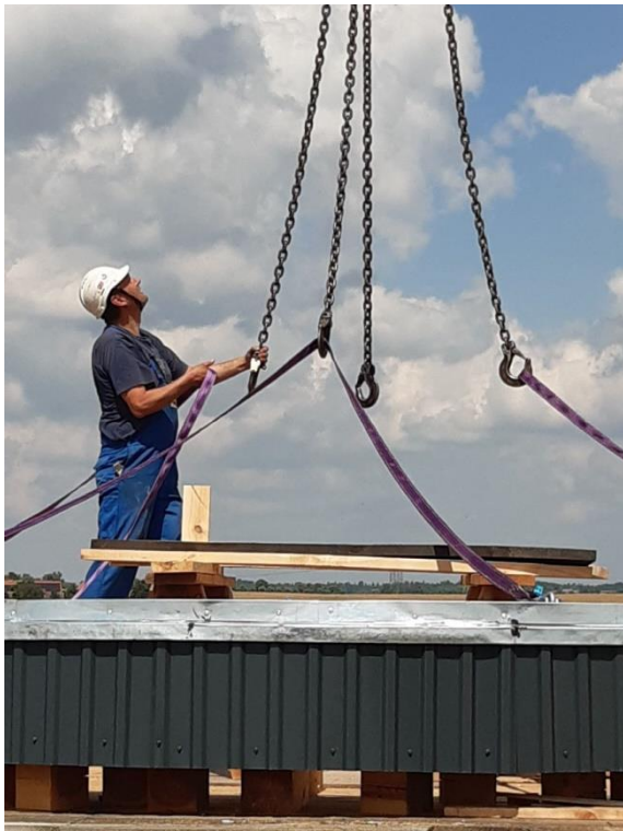
Der untere Drehkranz ist nun zugänglich und wird an die Kranhaken gehängt.
