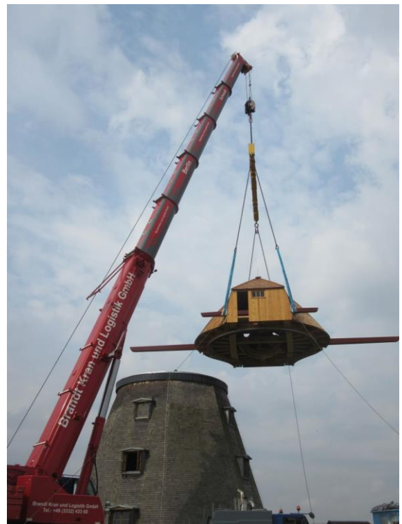
Die etwa 17 t schwere Kappe wird mit Seilen geführt und über dem Achtkant genau positioniert.
