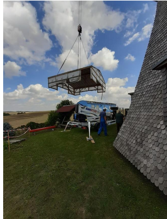
Nun wird das Montagezelt für den unteren Drehkranz hochgehoben und auf der anderen Seite des Mühlengeländes abgestellt.
