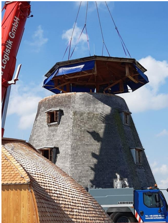
Das Behelfsdach wurde vom Mühlenackert gelöst und schwebt schon an den Kranseilen.
