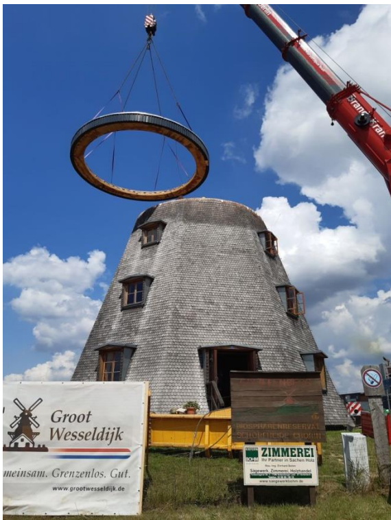
Hier schwebt er schon über dem Mühlenachtkant. Die untere Laufbahn, die Kugeln und der aus Segmenten zusammengebaute Kugelkäfig befinden sich schon auf dem Drehkranz.
