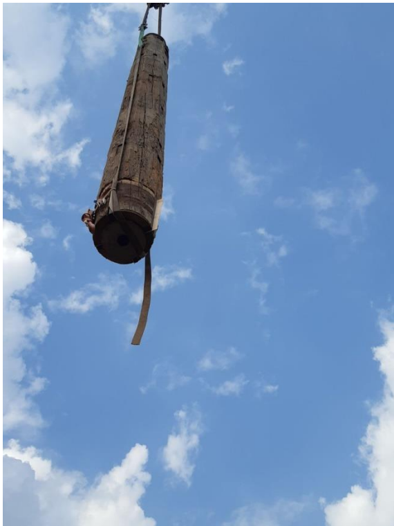
Als nächster Schritt folgt das Einsetzen der oberen Königswelle.
