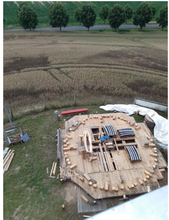
Ein Blick von oben auf die nun leere Montageplattform für den unteren Drehkranz.
